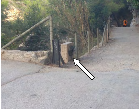
Balizas de iluminación horizontal existentes en el camino / vial de acceso a la Cala Deià.
