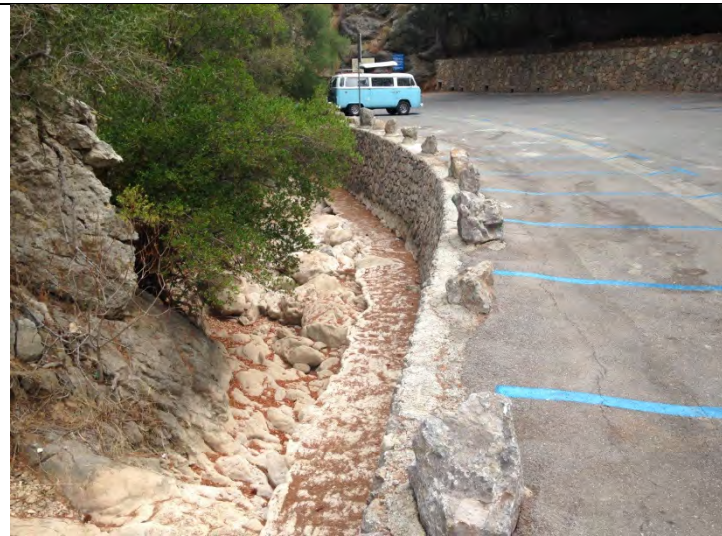
Vista del cauce del torrente lindante con el aparcamiento.
