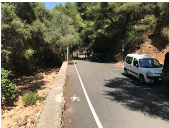
Murete bajo de piedra seca existente y tramo con rejilla sobre postes de madera tratada.
