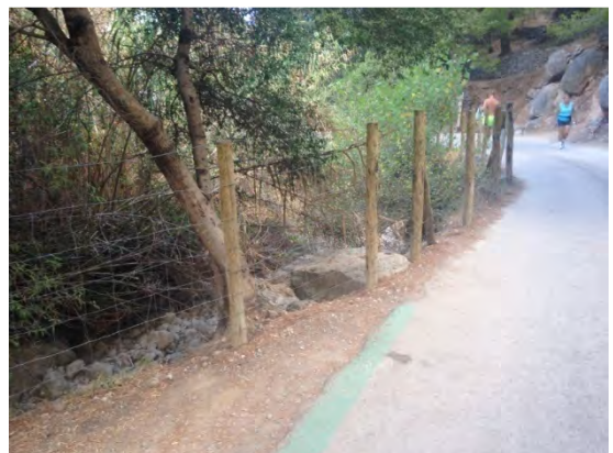
Murete bajo de piedra seca existente y tramo con rejilla sobre postes de madera tratada.
