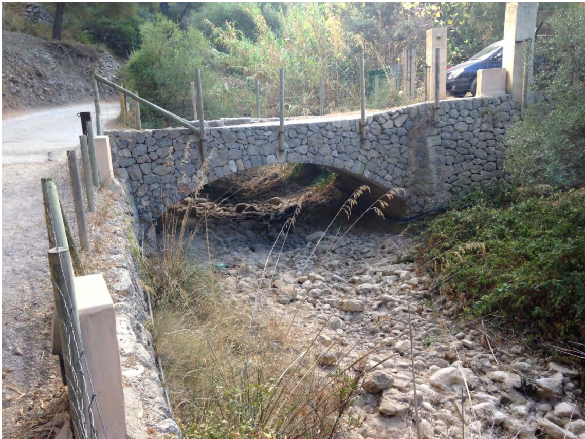
Lecho del Torrent Major a su paso por la obra de fábrica existente de acceso a Sa Cala.
