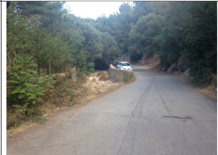
Tramo viario carente de aparcamientos por falta de espacio.
