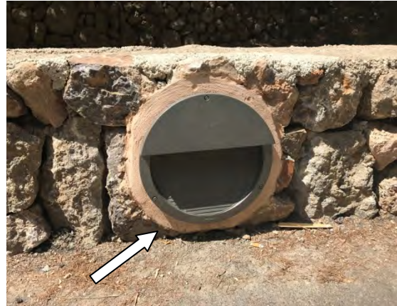
Balizas de iluminación horizontal existentes en el camino / vial de acceso a la Cala Deià.
