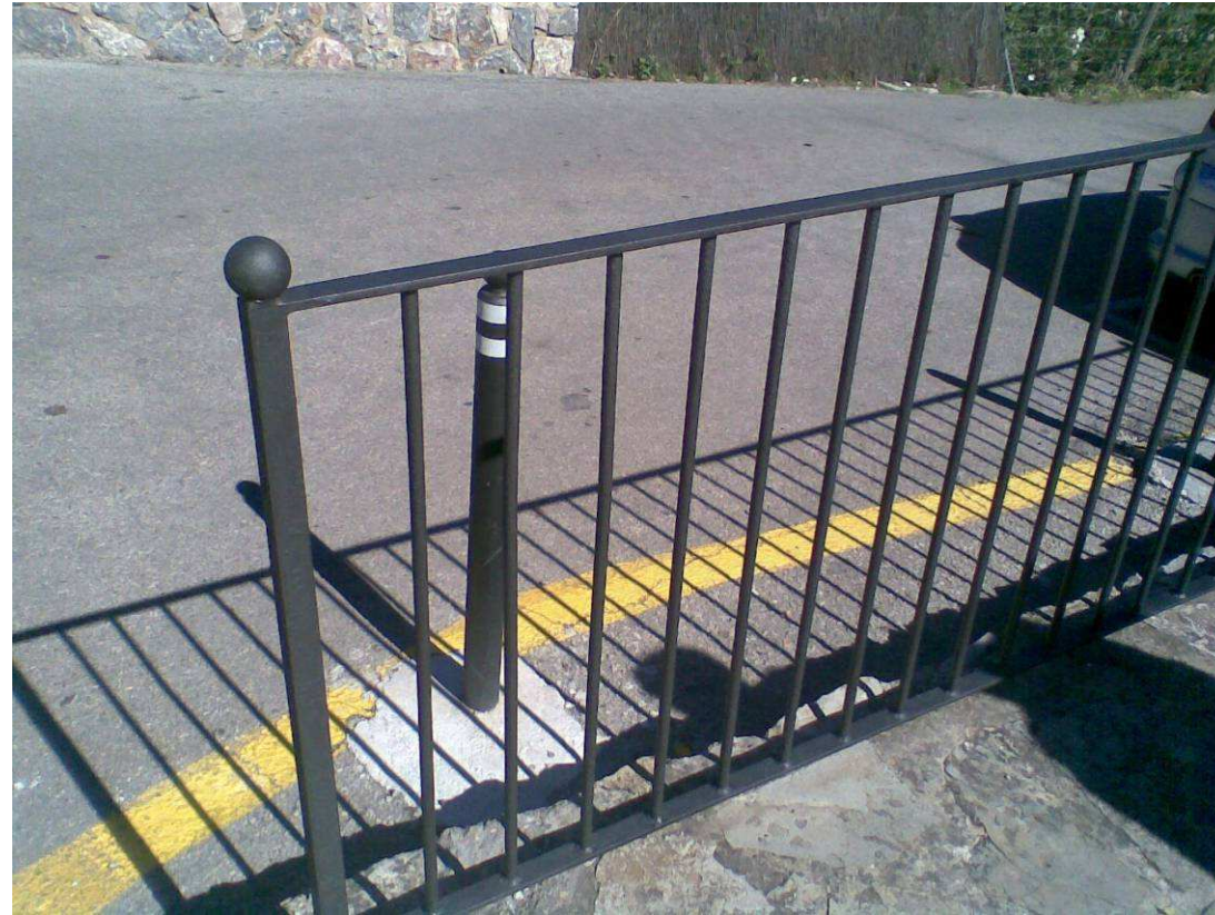
Barandilla existente .La nueva debe ser de idénticas características
