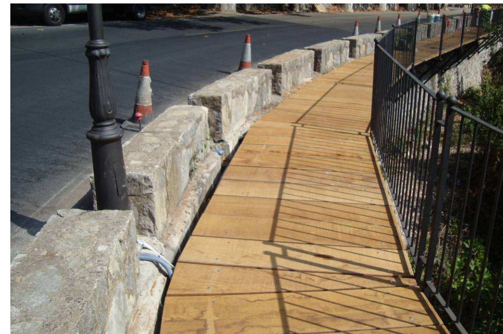
Actual tramo existente de pasarela en tramo contiguo al proyectado
